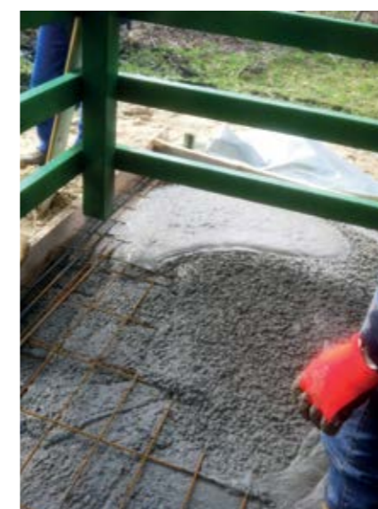
Schnell und mühelos konnten die Fundamente erstellt werden.
