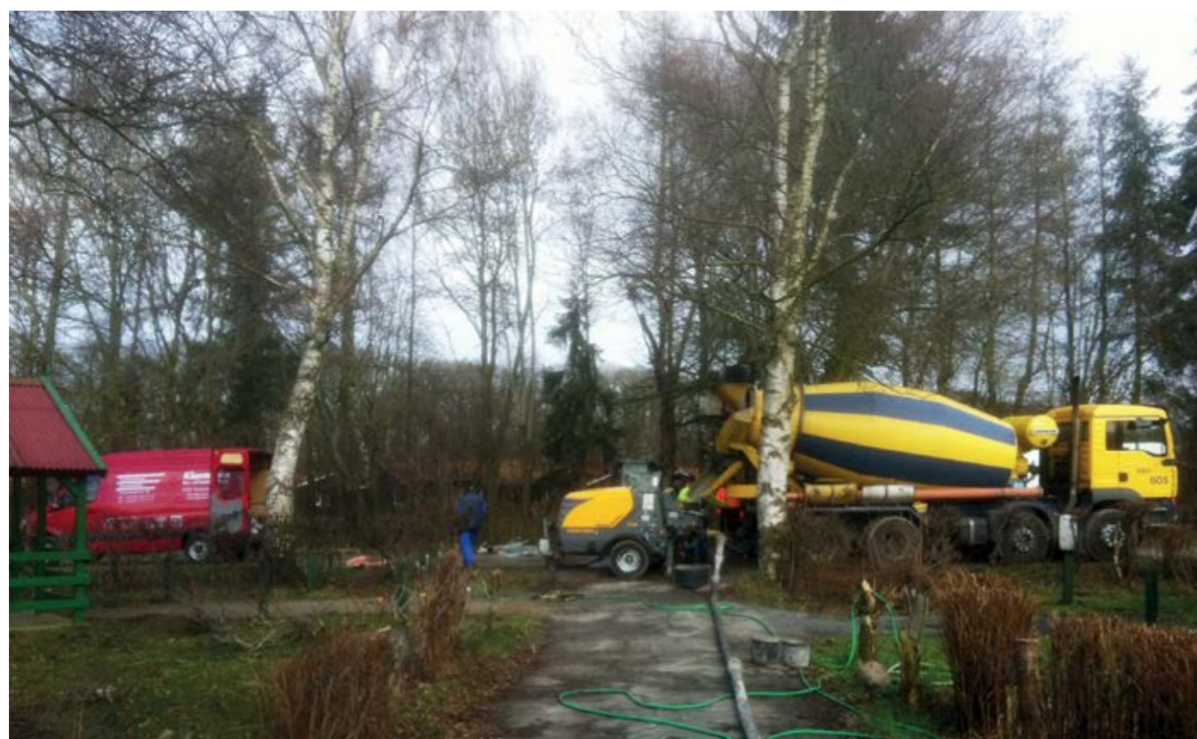
Die P 718 von Putzmeister pumpt den Beton über Schlauchleitungen bis 150 m weit direkt zur Einbringstelle.
